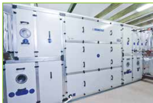
Centrala klimatyzacyjna ACAV Hi-ECO z technologią wysokoeffektywnego odzysku ciepła
