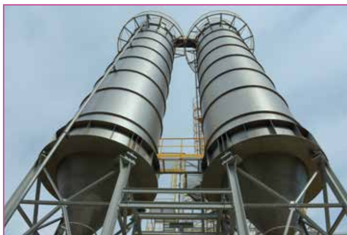
Budowa instalacji w Grupie Azoty ZAK S.A.
